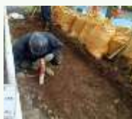
既存土壌すき取り
