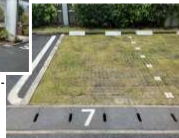
- 駐車場 改修後 -
