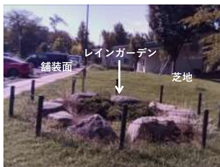
検証施設（目視の状況）
