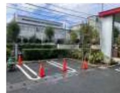
- 駐車場 改修前 -
