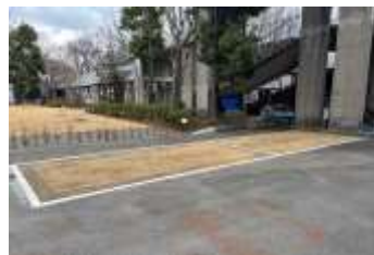
- 舗装道路部 改修後 -
